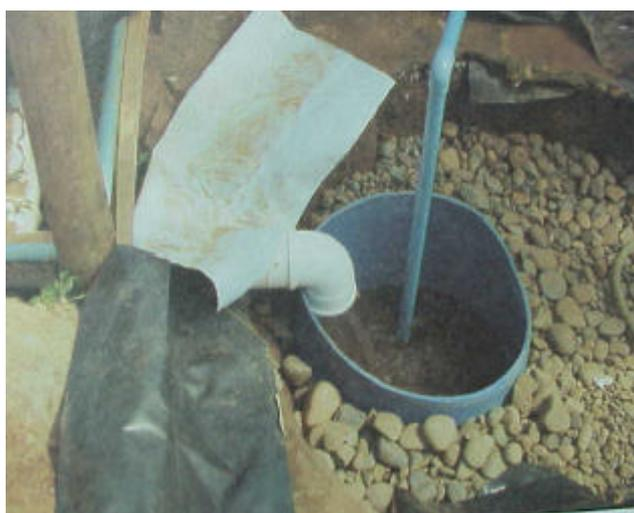
Fotografía 2: Estanque colector de PVC
