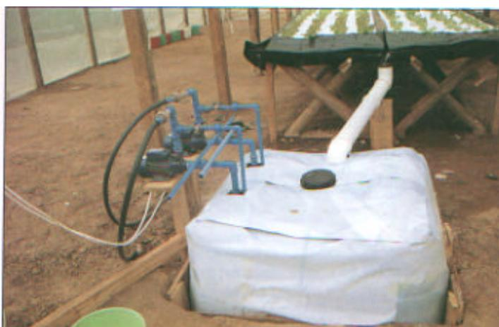
Fotografía 1: Estanque colector de plástico cubierto con polietileno coextrusado
