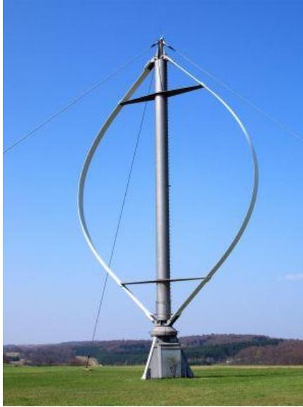
Fig. 4 Aerogenerador Darrieus
