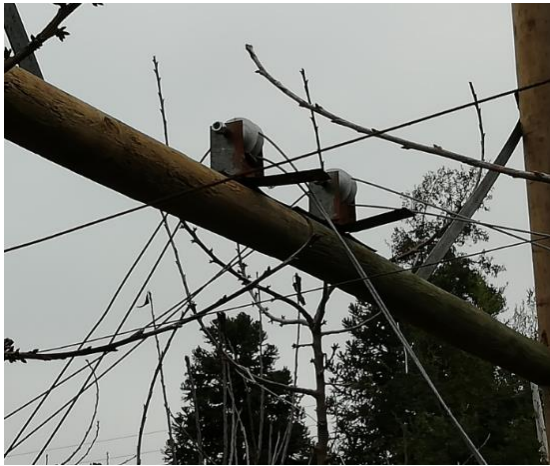
Fig. 3.18 Instalación cables de acero.
