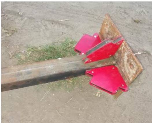
Fig. 3.5 Soldado placa de acero para soporte.
