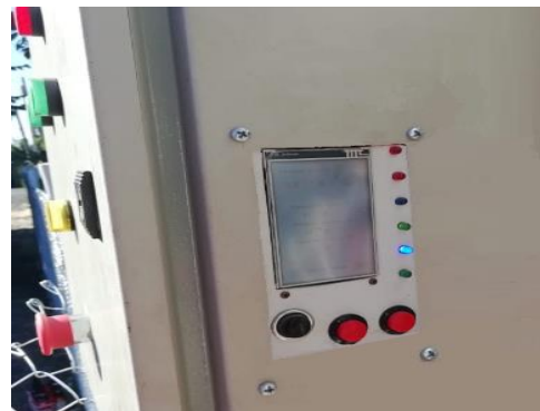
Fig. 4.33 Control instalado en tablero.
