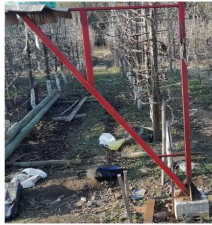
Fig. 3.15 Construcción estructura motor.
