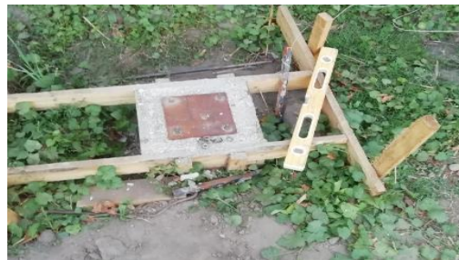
Fig. 3.4 Fundación terminada.
