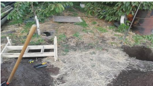
Fig. 3.3 construcción moldes fundación.
