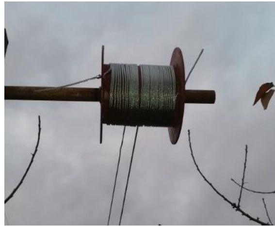
Fig. 3.19 Enrollamiento cable en tambor.
