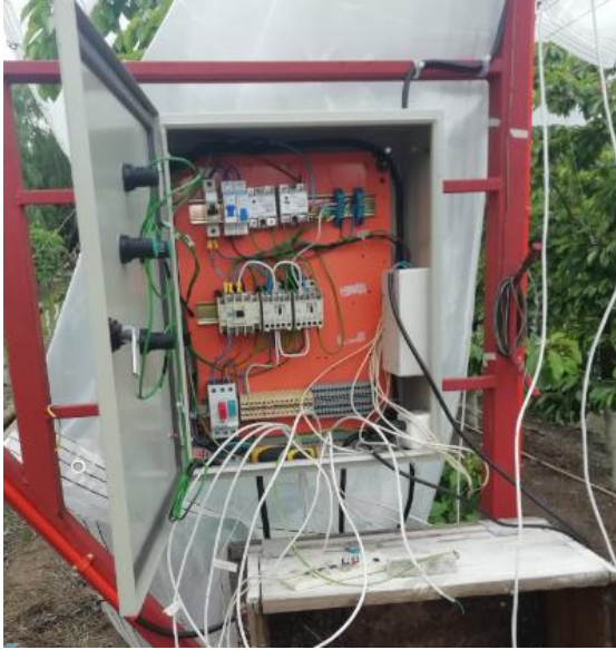
Fig. 4.36 Montaje tablero eléctrico.
