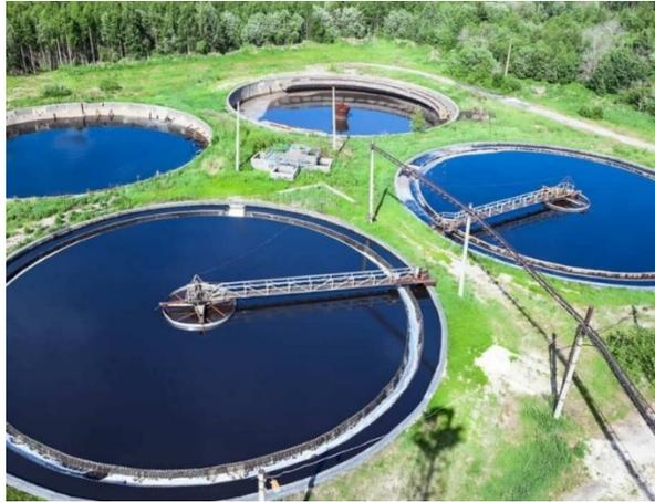
*Imagen 2. Tanque de tratamiento primario.*
