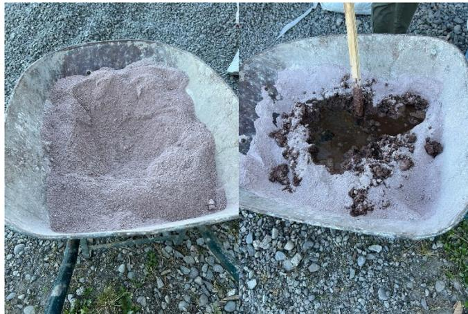
*Imagen 16. Mezcla cal hidráulica, tierra de color, arena y 10% de lodo.*
