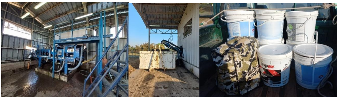
Imagen 22. Retiro lodo desde planta.
