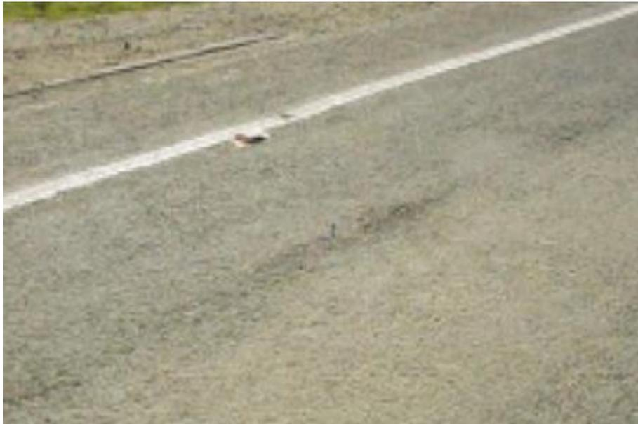
*Figura n° 10: “Pérdida de áridos en pavimento flexible”*
