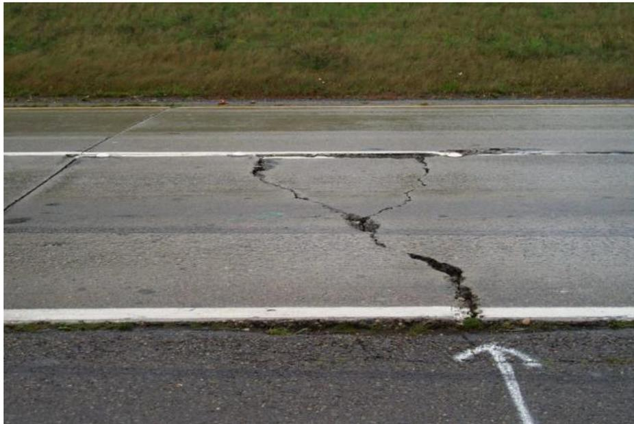
*Figura n° 6: “Falla transversal en pavimento flexible”*
