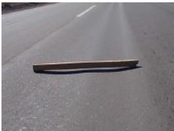
*Figura n° 8: "Ahuellamiento en pavimento flexible"*
