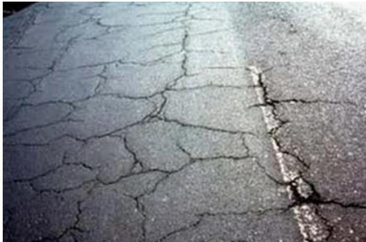
*Figura n°4: “Falla por bloques de un pavimento flexible”*
