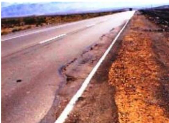
*Figura n°3: “Falla de borde en pavimento flexible”*
