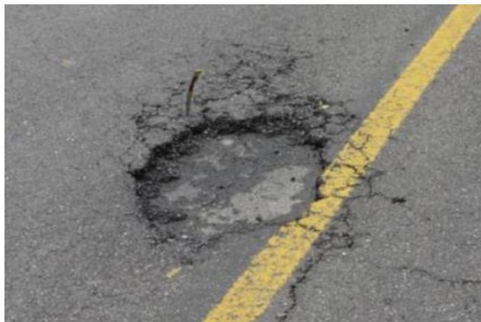
*Figura n° 7: "Bache en pavimento flexible"*
