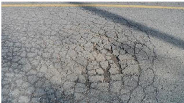
Figura n°2: "Falla por fatiga en pavimento flexible"
