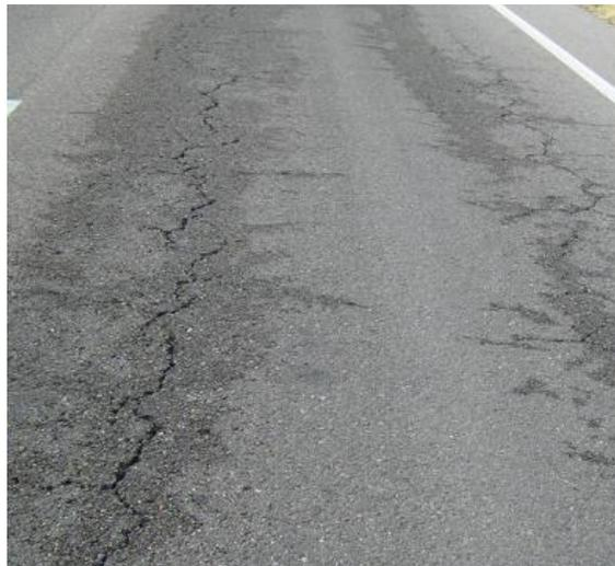
*Figura n°5: "Falla longitudinal en pavimento flexible"*
