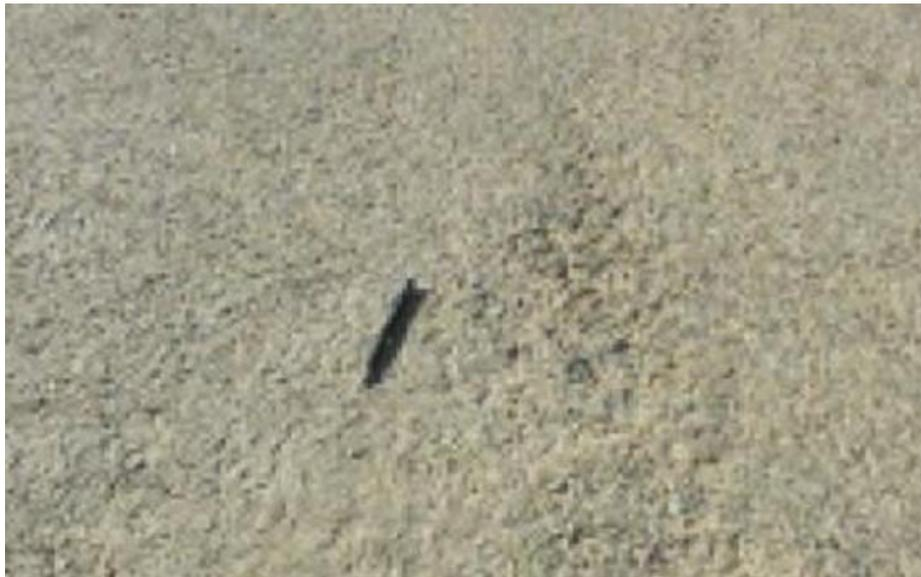
*Figura nº 9: “Desgaste en pavimento flexible”*
