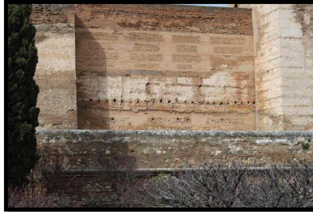
Ilustración 2: “Muro defensivo de Alhambra de Granada, España”
