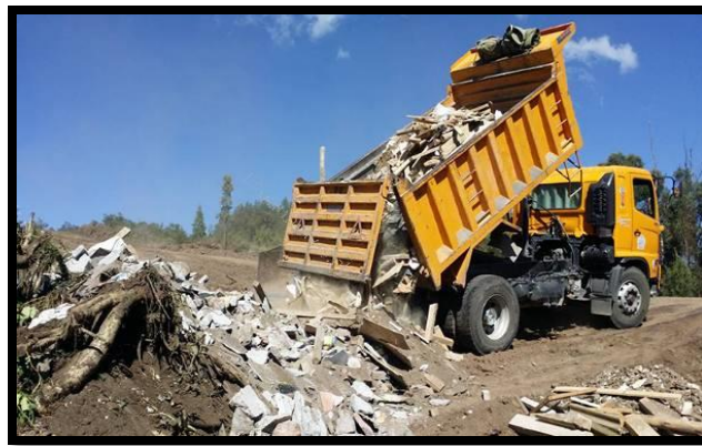
Ilustración 3: “Botadero de escombros de construcción”
