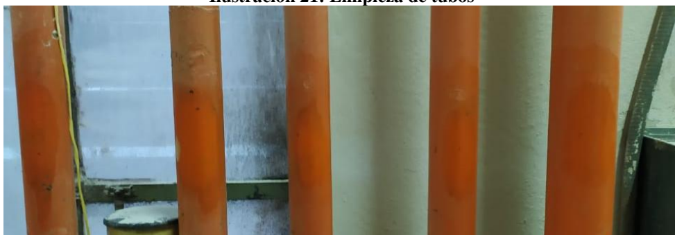
Ilustración 21: Limpieza de tubos
