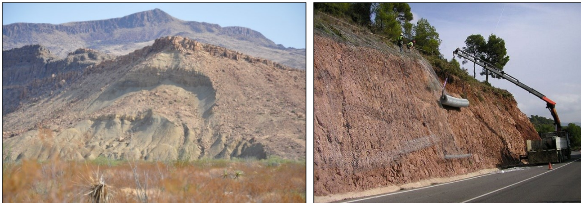
Figura 2.2: Izquierda, talud natural en Big Bend National Park, USA. Derecha, talud artificial en Valencia, España.
