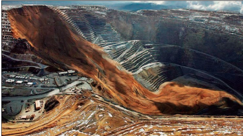
Figura 1.1: Colapso o falla de un talud en rajo minero en Bingham Canyon Mine, Utah. Fuente: Revista Seguridad Minera.
