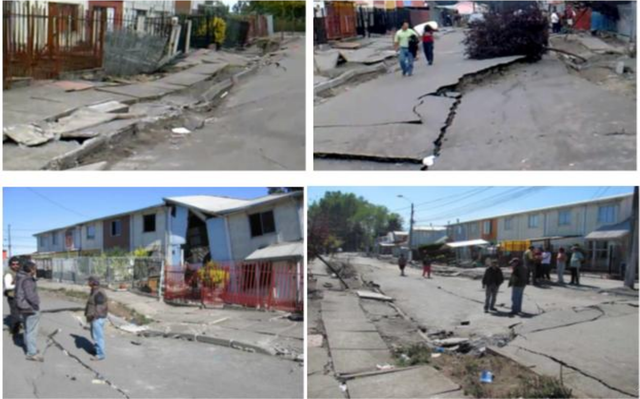
Ilustración 44: Grietas en calzada y vivienda, debido al hundimiento del terreno.
