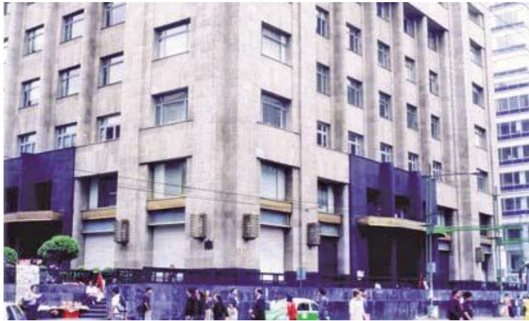
Ilustración 22: Edificio que presenta el fenómeno de emersión.
