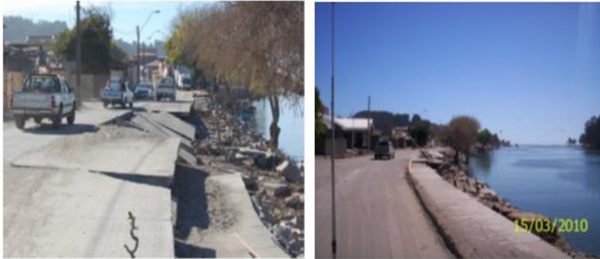
Ilustración 34: Desplazamientos provocaron grietas y desplomes en la calzada.
