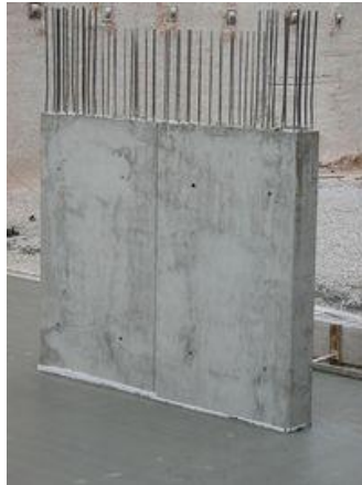
Ilustración 13: Muro de hormigón armado en una edificación.
