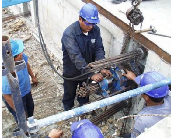
Ilustración 7: Proceso de pretensado de los tendones que se ubican dentro de las vainas.
