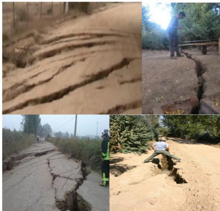
Ilustración 49: Daños provocados por el hundimiento del terreno a terrenos.
