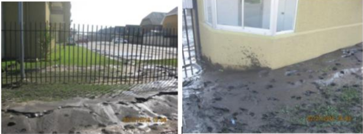
Ilustración 47: Surgimiento de aguas subterráneas.
