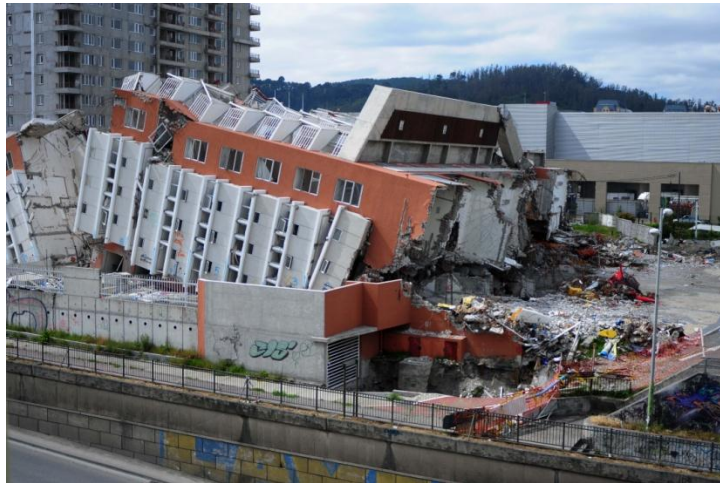
Ilustración 28: Colapso edificio Alto Río.
