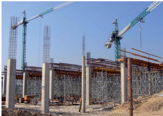
Ilustración 8: Diversos pilares de hormigón armado, de una estructura.
