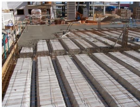
Ilustración 14: Forjado en proceso de vertido de hormigón.
