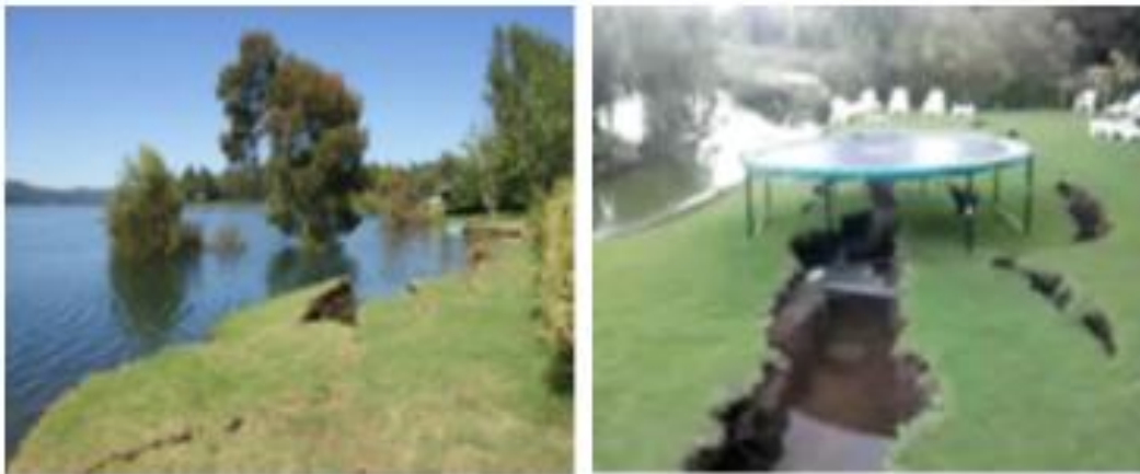
Ilustración 33: Desplome y hundimiento de terrenos por la orilla del lago.
