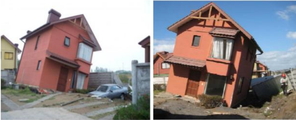
Ilustración 39: Inclinación de vivienda debido al hundimiento del terreno.
