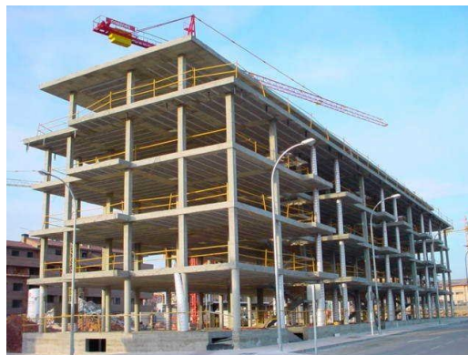
Ilustración 5: Estructura de hormigón armado en proceso de construcción.
