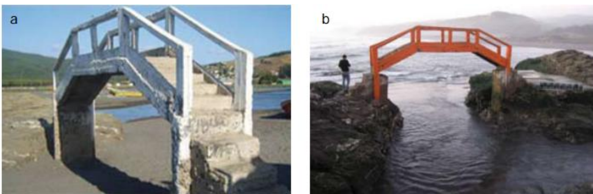
Ilustración 27: Bucalemu, afectado por Subsidencia.
