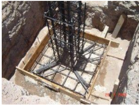
Ilustración 11: Cimentación superficial, zapata en pleno proceso constructivo.
