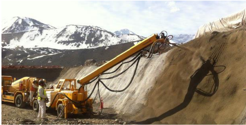
Ilustración 18: Colocación de hormigón proyectado
