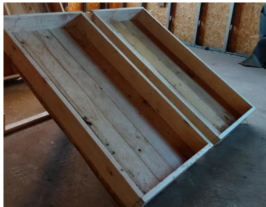
Ilustración 21: Confección de talud
