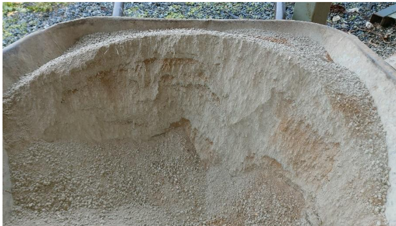
Ilustración 25: Incorporación de cemento al suelo
