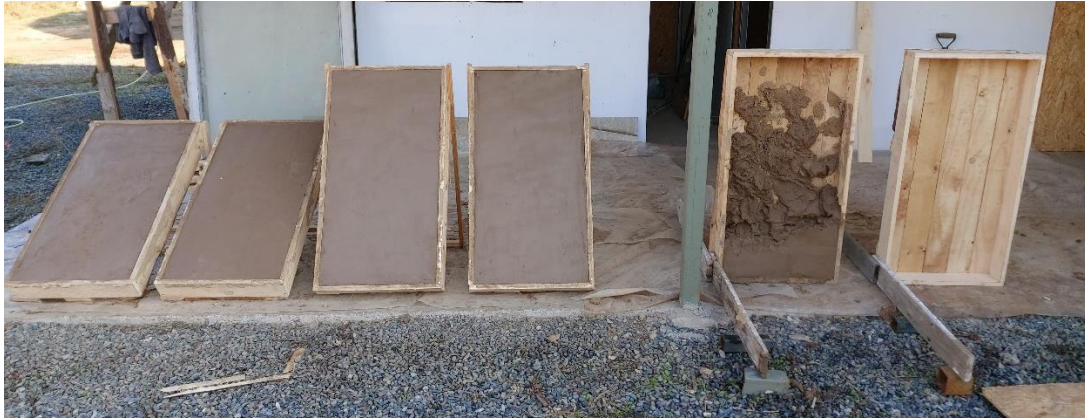
Ilustración 26: Aplicación de mezcla de suelo cemento
