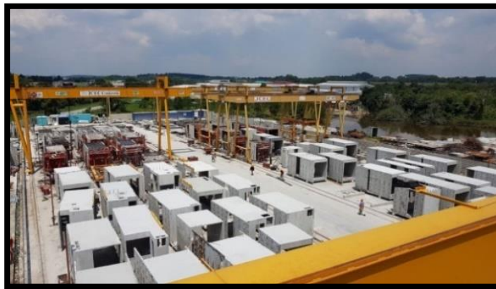
Ilustración 5: Cimientos / Dragages Singapore
