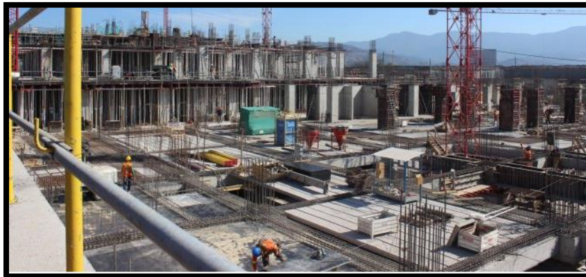
Ilustración 35: Construcción Hospital biprovincial Quillota/Petorca Fuente: ssvq.cl – Servicio de salud Viña del Mar Quillota
