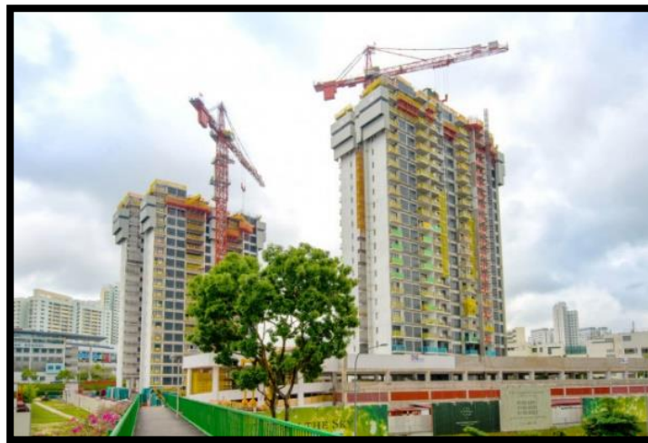
Ilustración 7: Torres en construcción / Dragages Singapore
