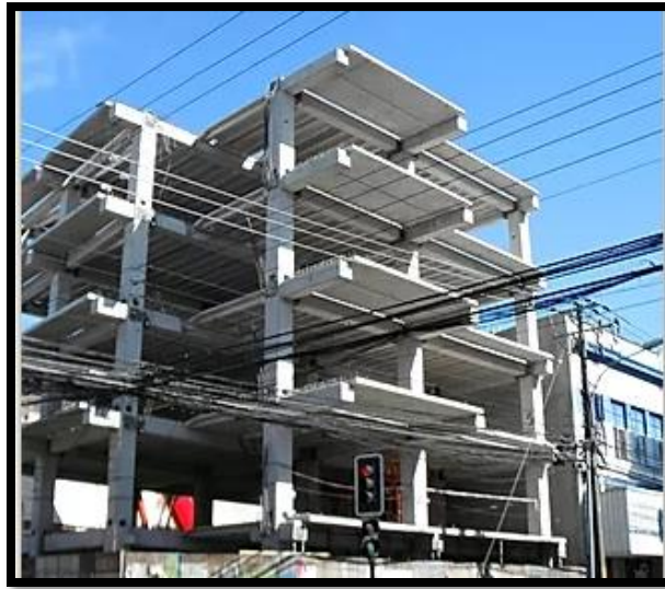
Ilustración 36: Montaje edificio Chacay
