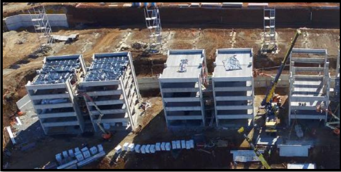
Ilustración 37: Construcción condominio Lomas de Javiera
