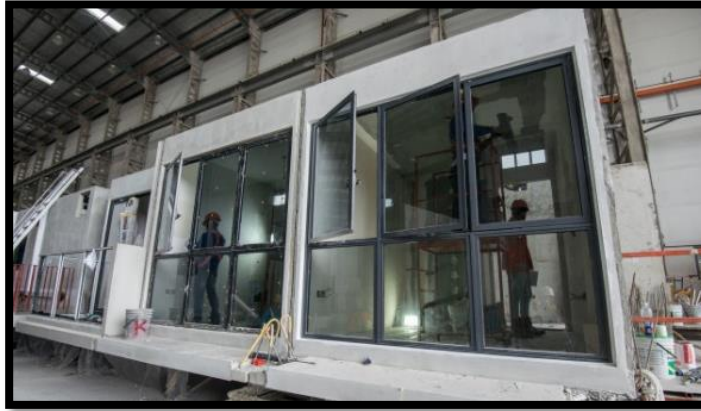
Ilustración 4: Formado por bloques de hormigón / Dragages Singapore
