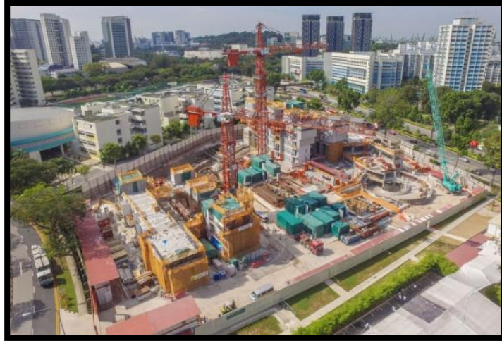
Ilustración 6: Vista aérea de emplazamiento / Dragages Singapore
