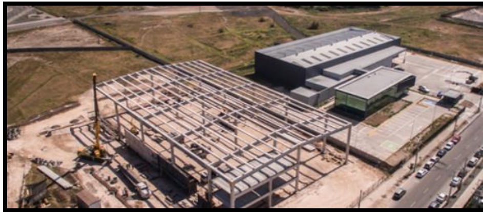
Ilustración 33: Naves Industriales, bodegas EIT
