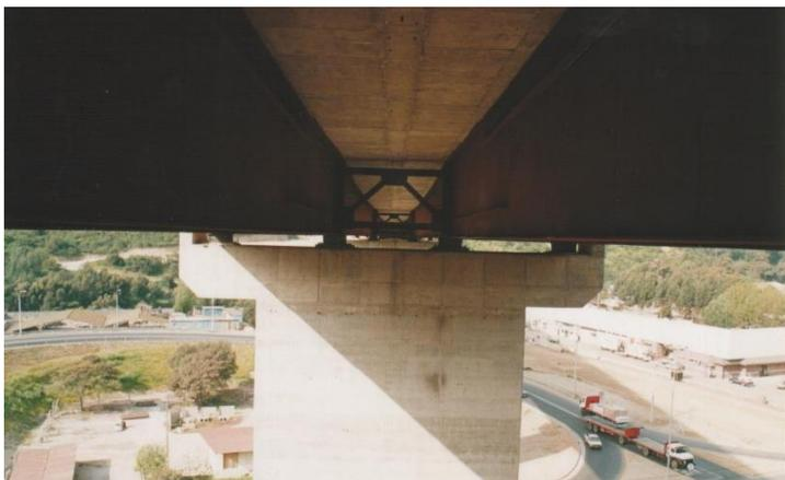
Figura N°2.10: Viaducto Marga-Marga con sistema de aislamiento sísmico.
