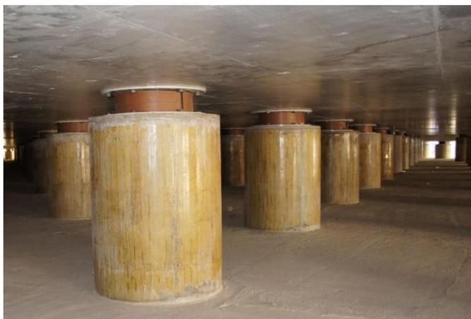
Figura N°2.15: Estanque de gas GNL Mejillones, con sistema de aislamiento sísmico.
