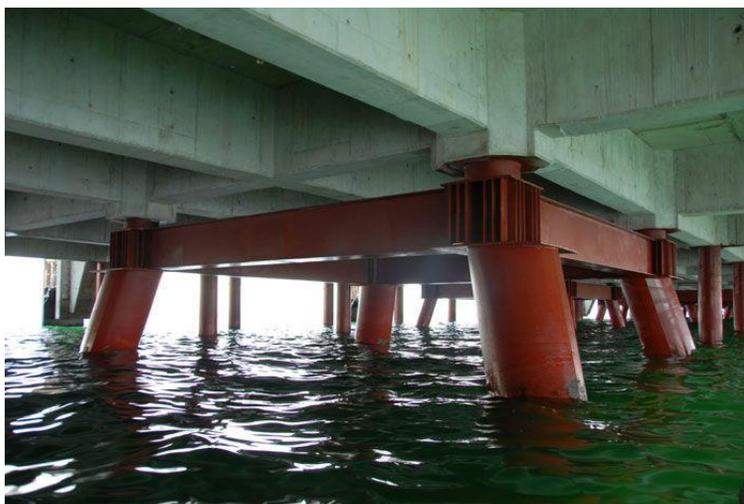
Figura N°2.13: Muelle del puerto de Coronel, con sistema de aislamiento sísmico.
