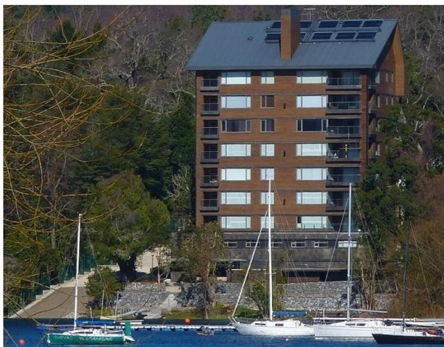
Figura N°2.14: Edificio Marina Paihuen, posee sistema de aislamiento sísmico.
