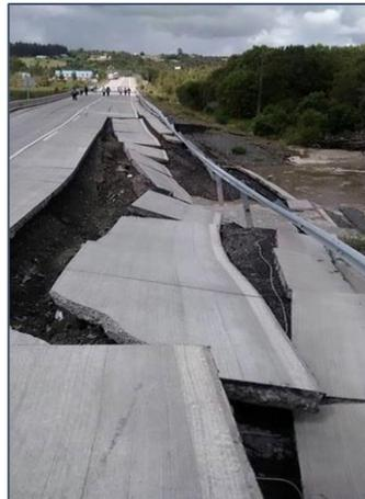
**Ilustración 25:** Desplazamiento lateral registrado durante el terremoto de Chiloé en el año 2017
