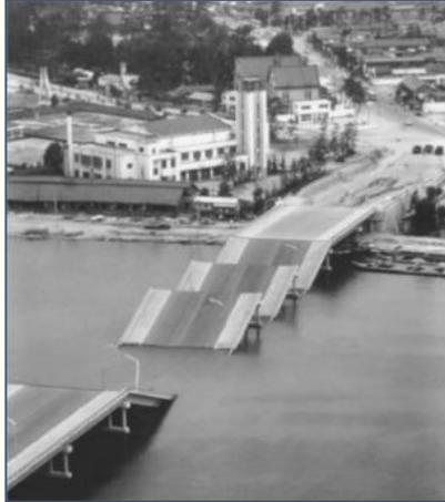
**Ilustración 24:** Falla por desplazamiento lateral puente Showa, Terremoto Niigata en el año 1964
