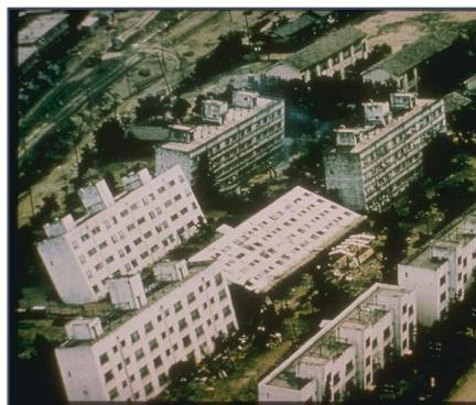
**Ilustración 21:** Colapso de estructura por movilidad cíclica, terremoto Niigata año 1964
