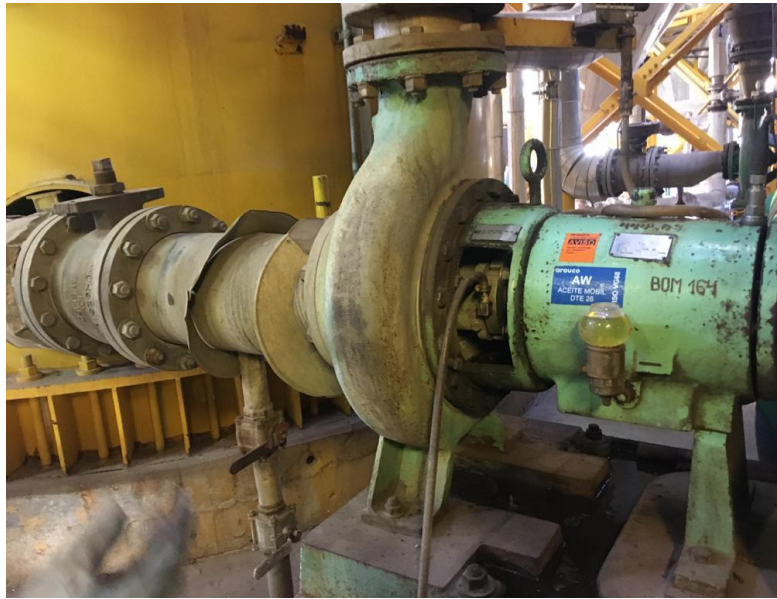
Figura 4-6: Nivel corregido de lubricante en bomba, fuente propia
