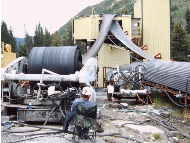
Figura 2.15.: Instalación Correa Contitech Continental.
