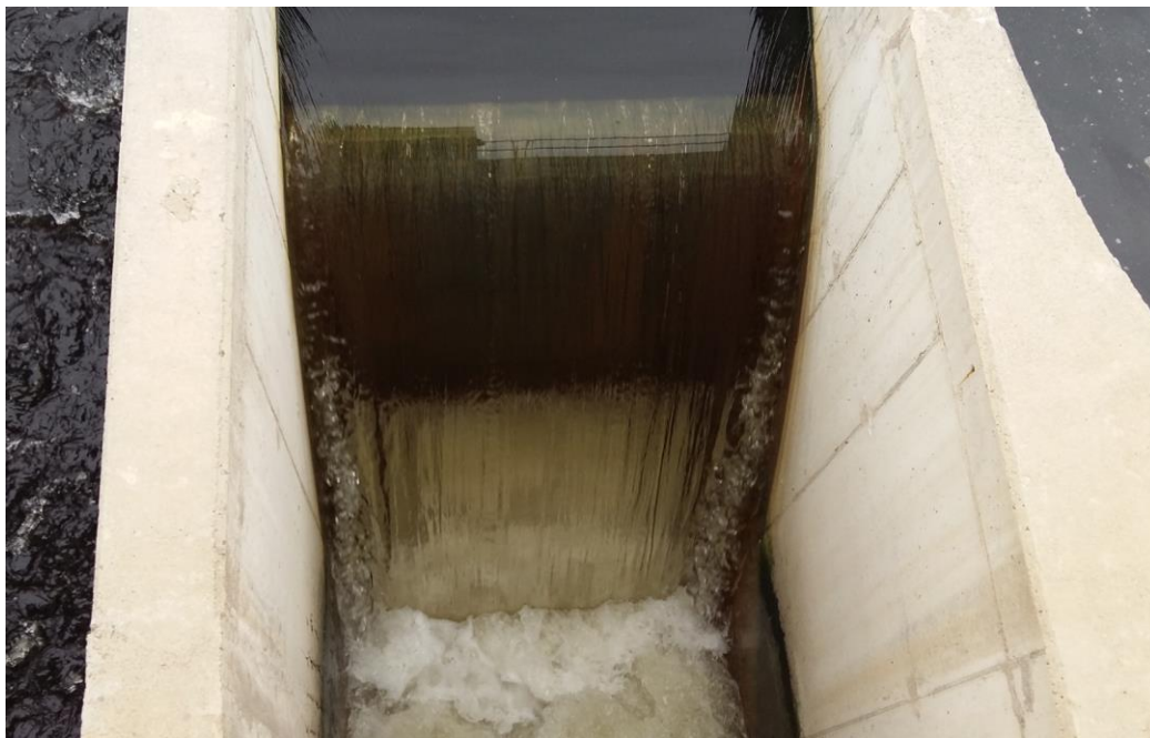
Ilustración 16: Salto Dónde se instalará la turbina (Fuente: Elaboración propia)
