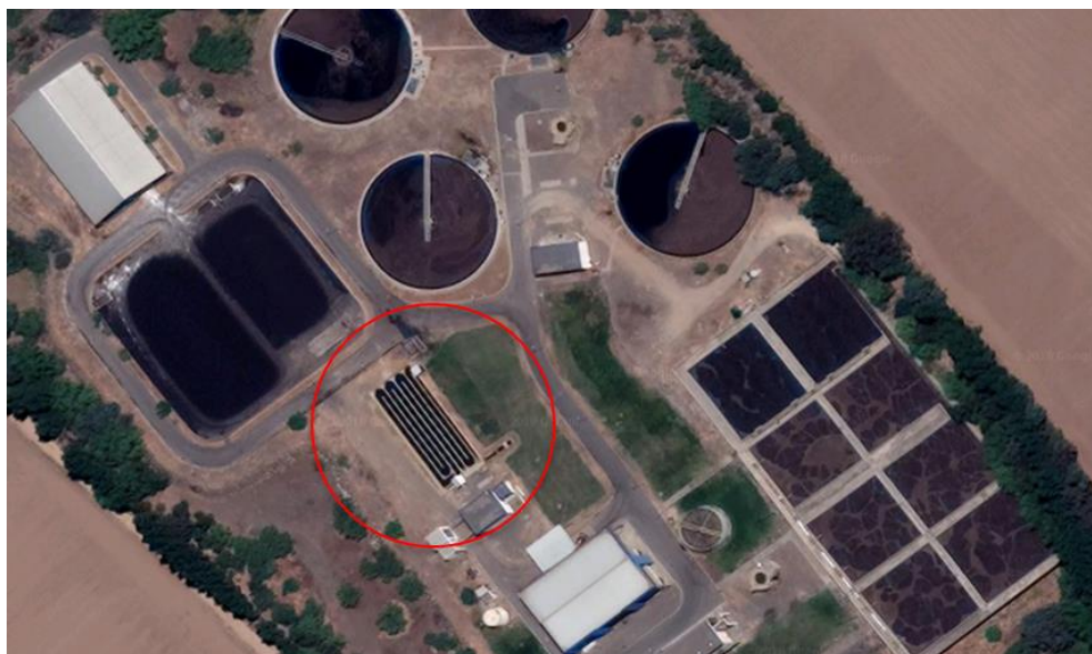
Ilustración 13: Planta de tratamiento de aguas servidas Talca (Fuente: Google Map)
