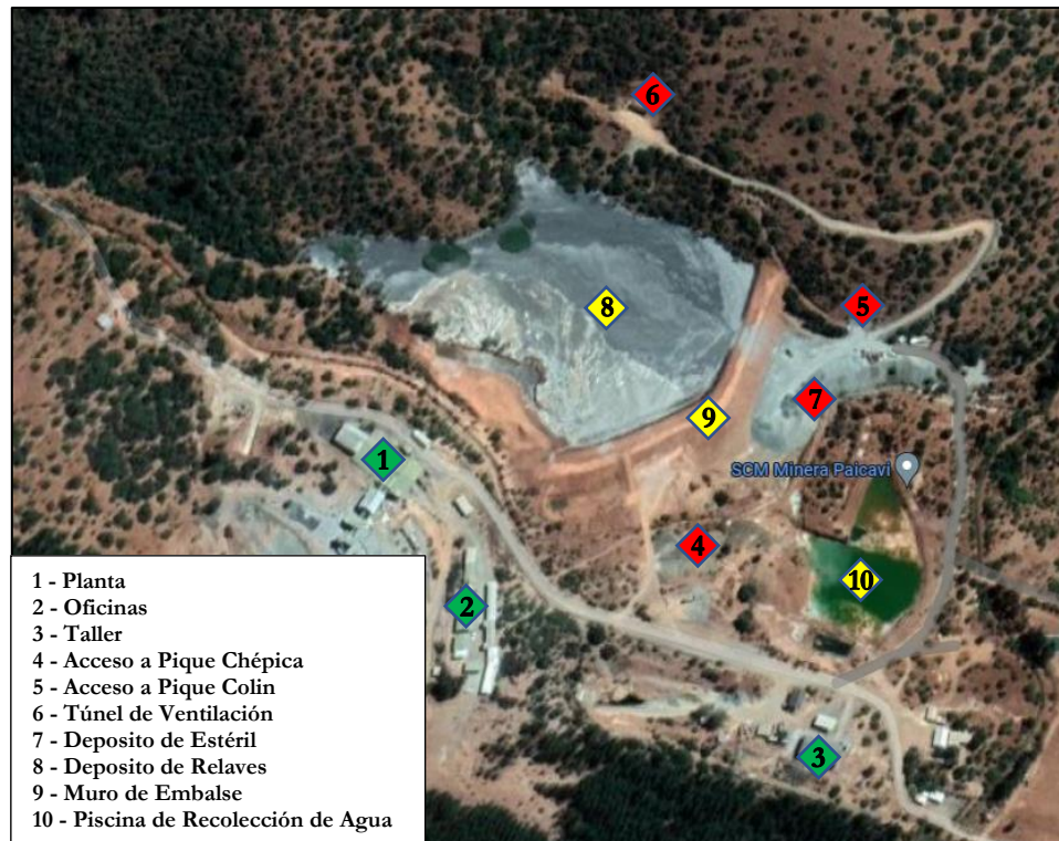
Figura 1.3 Principales instalaciones de Mina Chépica
