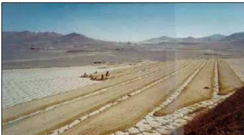
Figura 2.13: Panorámica construcción de drenes basales en Botaderos de Ripios.
