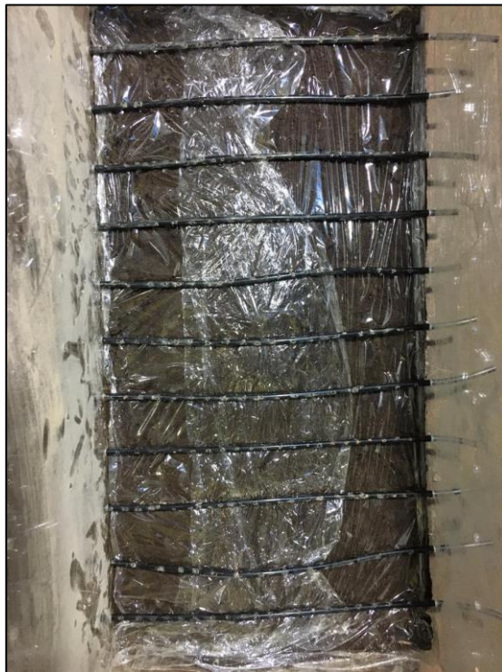
Figura 4.25: Instalación de geomembrana para el Experimento.
