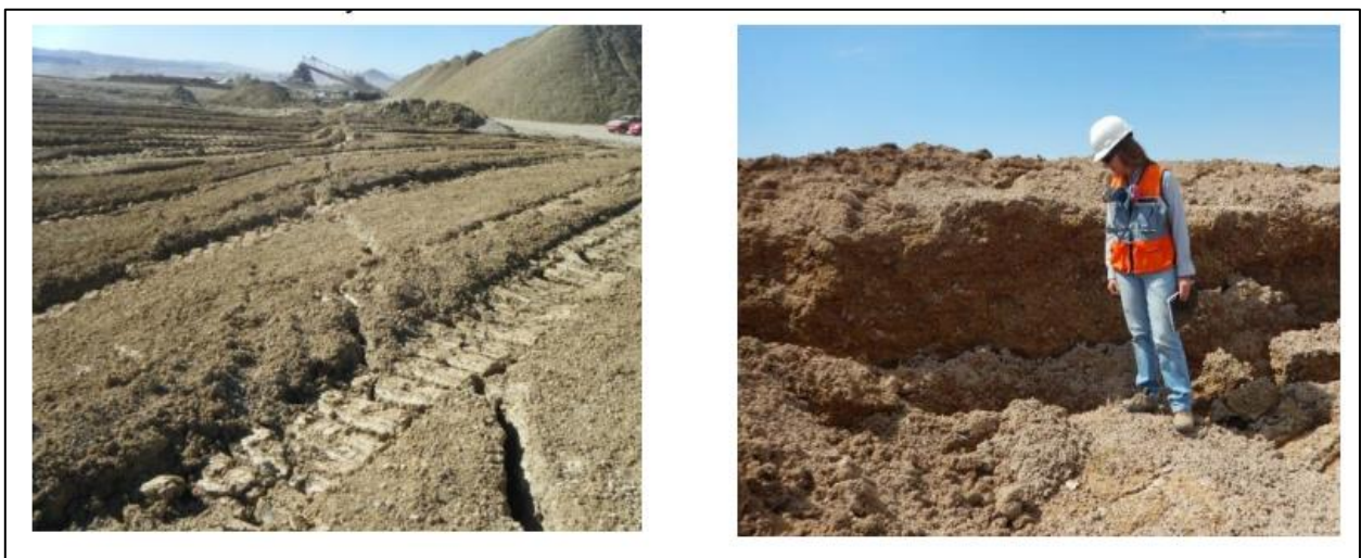
Figura 2.12: Observaciones de grietas y asentamientos en terreno Botadero de Ripios.
