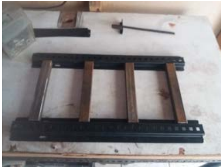
Figura 2.4: Construcción de plataforma
