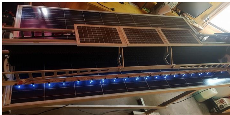
Fig.7.13: Escaneo sobre panel fotovoltaico sin suciedad.
