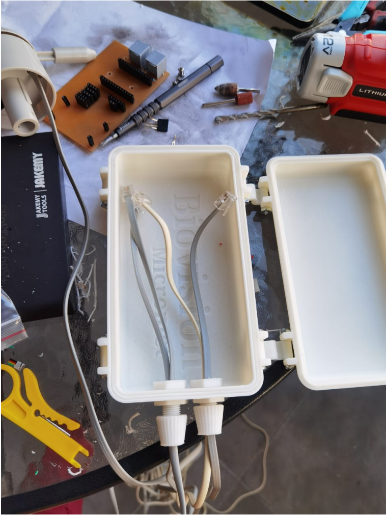
Figura E.2: Armado cableado estación meteorológica
