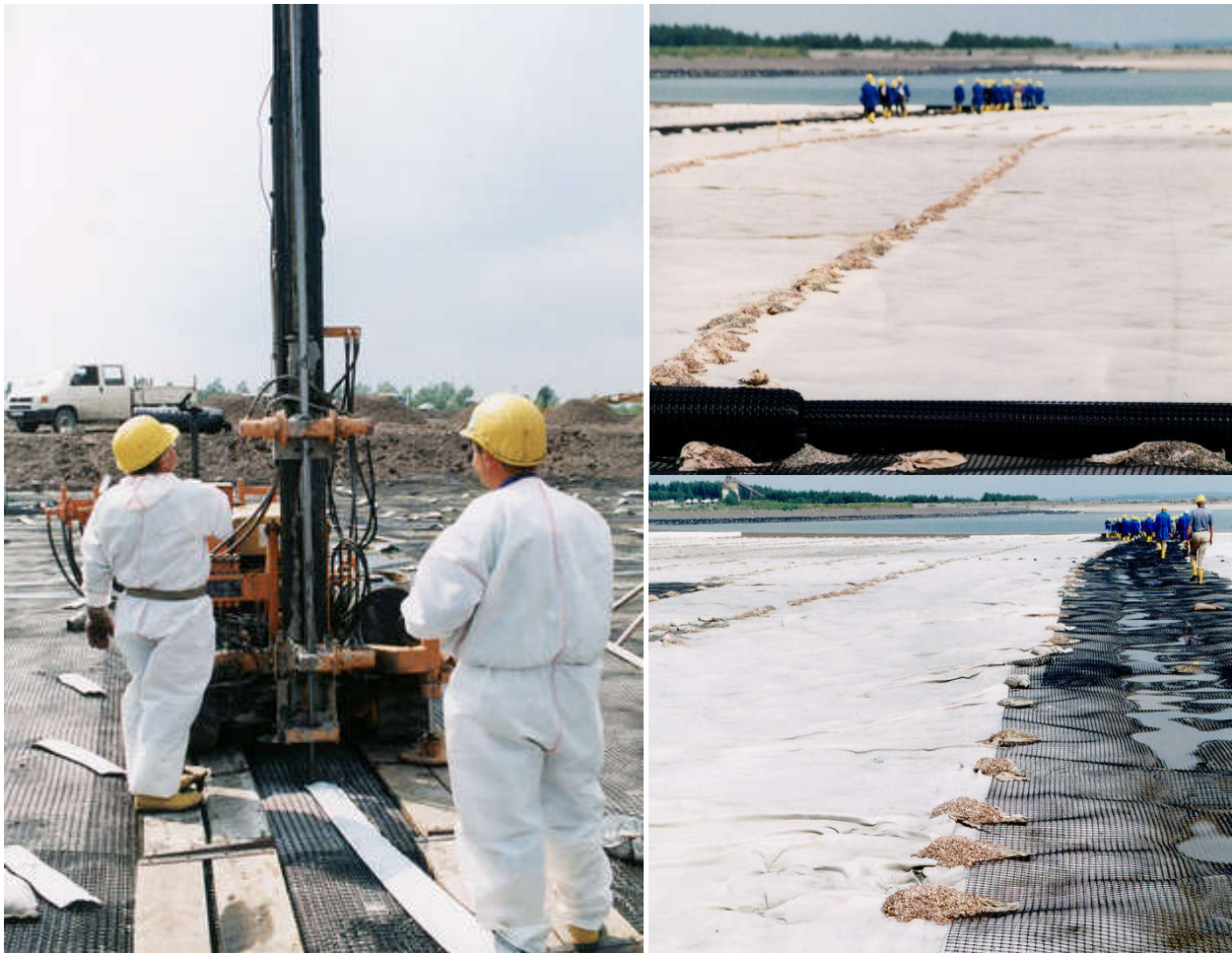
Ilustración 2.3: instalación y mantenimiento de geomembrana en depósito de relave Fuente: (McKenna, 2014)
