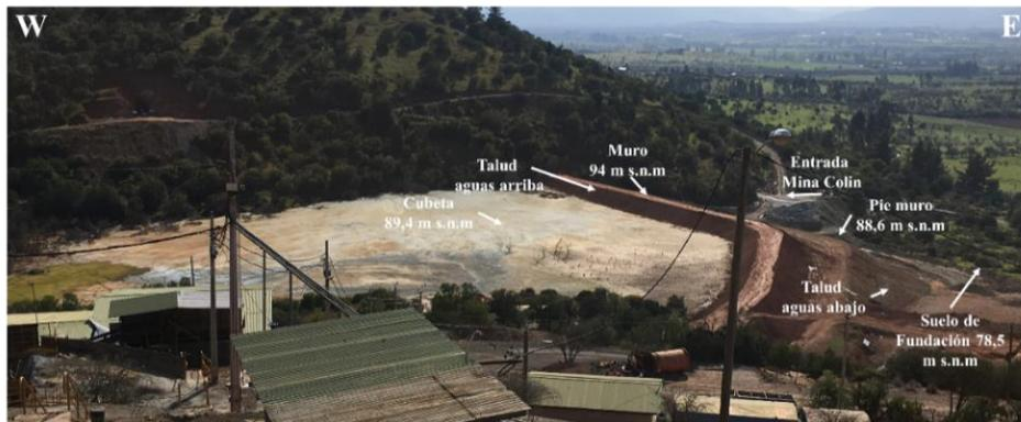
Figura 4-9: Fotografía etapa 2 embalse de relaves mina Chépica, vista desde planta de procesamiento de minerales - octubre,2018
