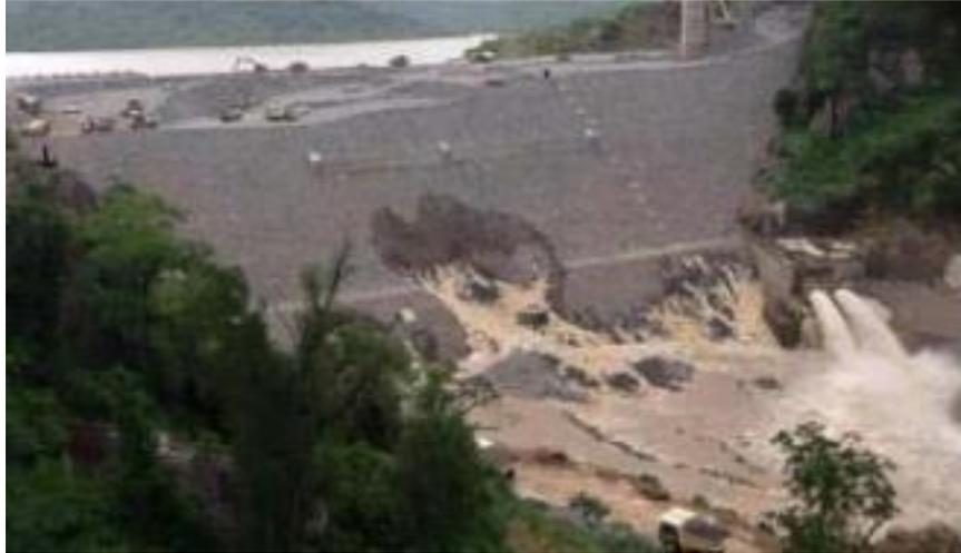
*Figura 2-9: Vista Falla por Tubificación
