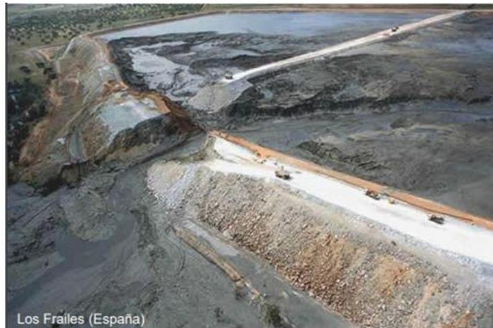
*Figura 2-4: Vista Falla de Fundación presa Aznacóllar, Mina Los Frailes, (Palma,2016)*
