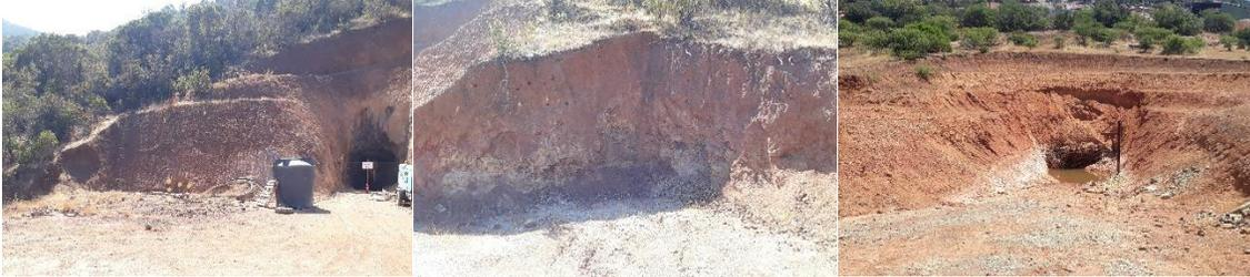
Figura 4.38 Fotografías en el cerro y en el acceso a túnel Chépica donde se puede observar un nivel de suelo entre 1 y 3 metros para las laderas del cerro y de 2 a 11 metros para las zonas planas (Elaboración propia).
