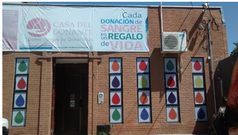
Figura 7: Fachada de la CDSM ubicada en la ciudad de Talca.
