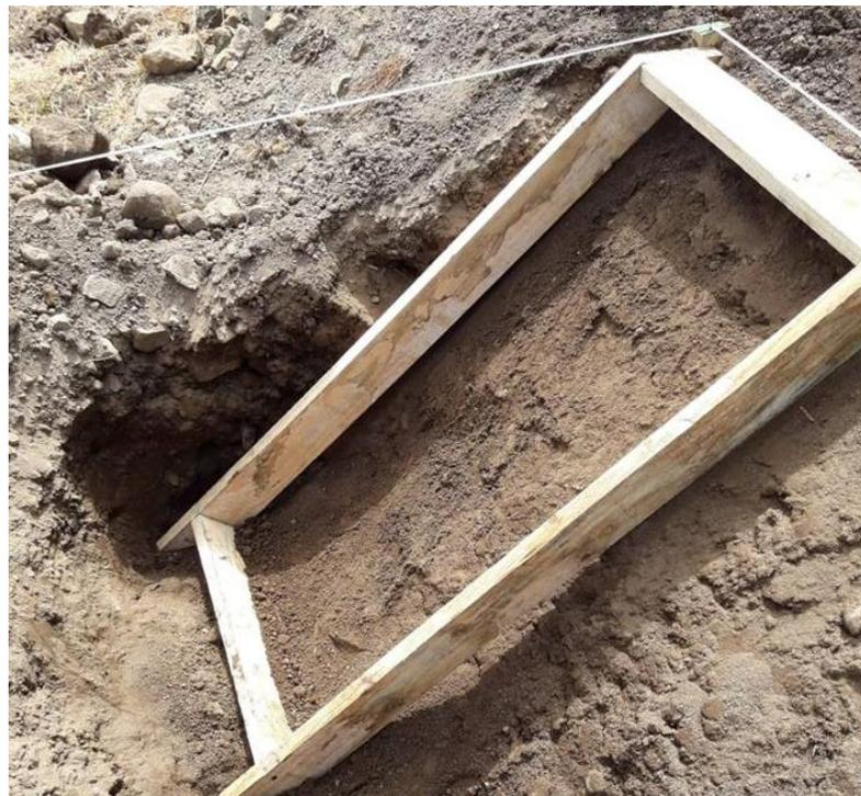
*Ilustración 29: Colocación de moldajes.*
