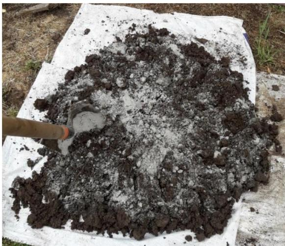
*Ilustración 30: Preparación de la mezcla de suelo-cemento.*
