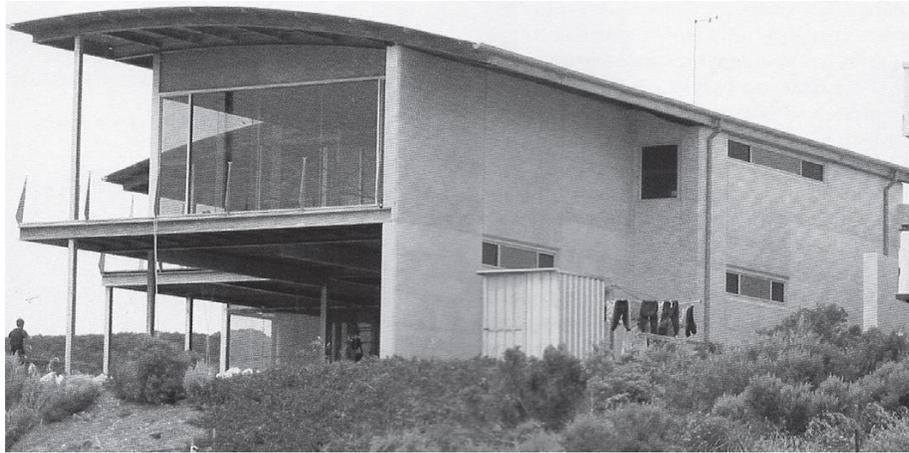
*Ilustración 13: Casa de suelo-cemento compactado construida por la empresa Ramtec, Margaret River, Australia.*
