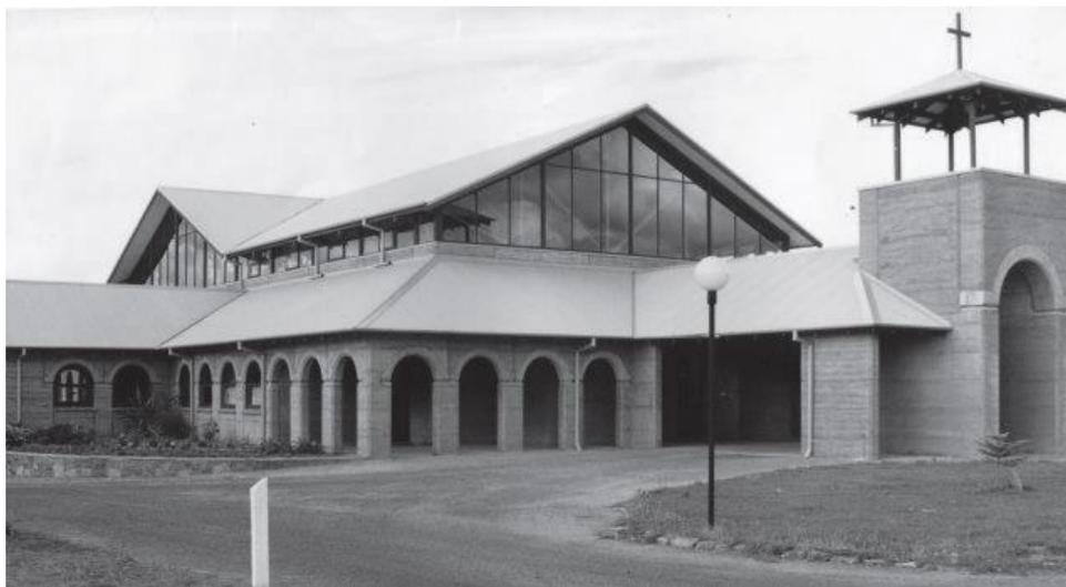
*Ilustración 14: Iglesia de suelo-cemento compactado construida por la empresa Ramtec, Margaret River, Australia.*
