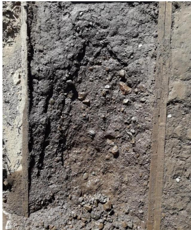
*Ilustración 44: Desprendimiento de material del talud 1.*
