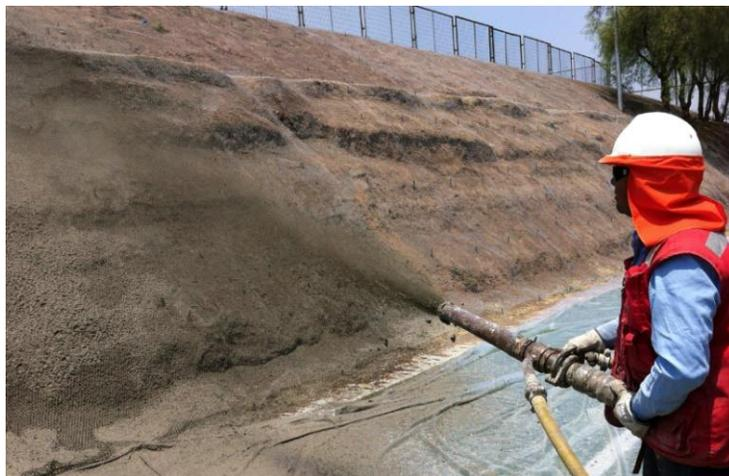
*Ilustración 10: Proyección de mortero (shotcrete) sobre talud.*
