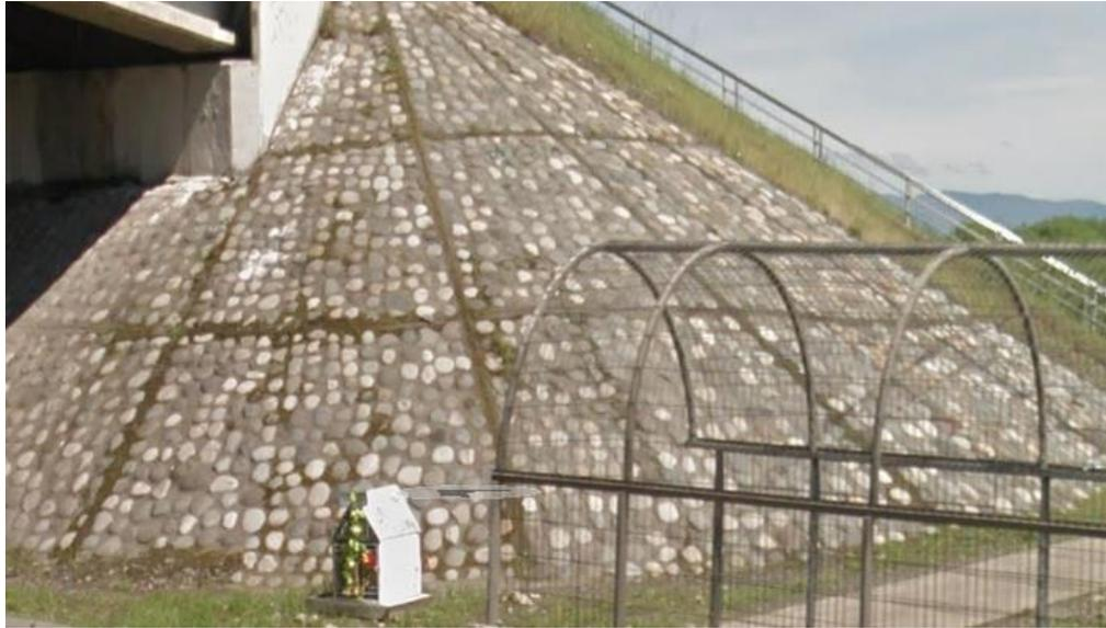
*Ilustración 9: Talud protegido con mampostería de piedra.*
