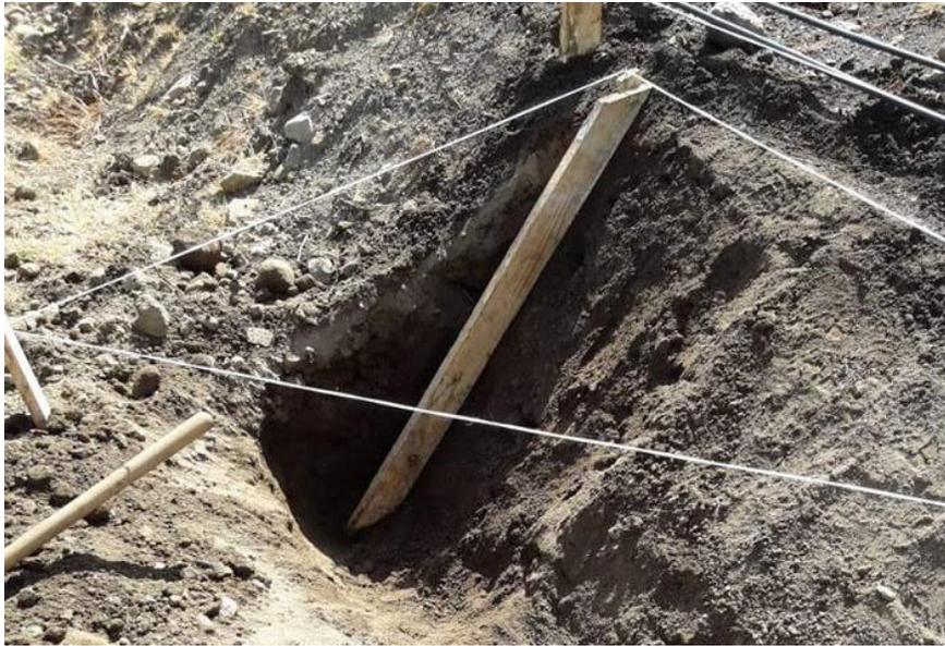
*Ilustración 28: Conformación del talud.*
