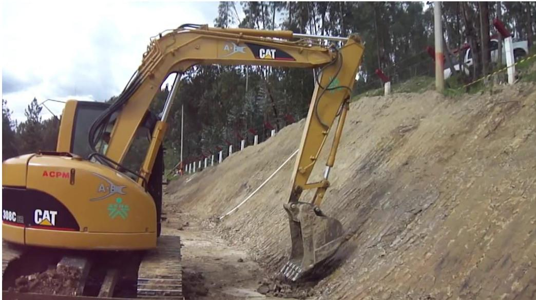
*Ilustración 5: Corte de talud con maquinaria.*
