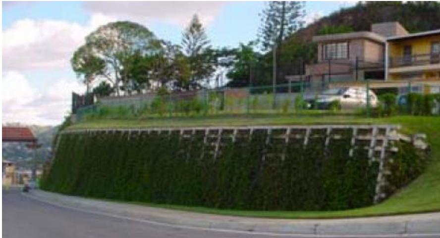
*Ilustración 11: Muro criba (cribwalls).*
