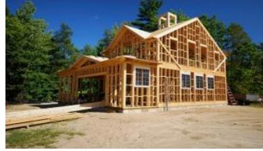
Imagen 54 / Estructura de madera.
