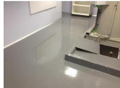
Imagen 19 / Hormigón recubierto con resina epoxi.
