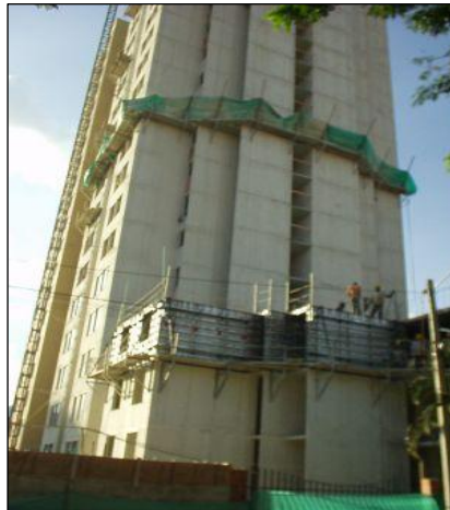
Imagen 33: Edificación en altura con muros de hormigón armado.
