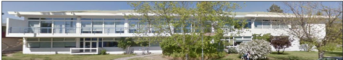
Imagen 51: Escuela de Arquitectura.
