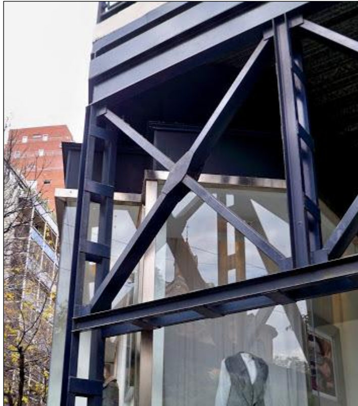
Imagen 34: edificación con cruces de san Andrés.
