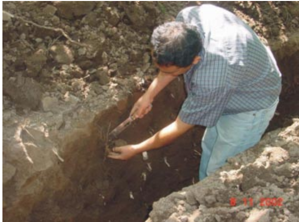
Foto 23. Control de la humedad a través del uso de calicatas.
